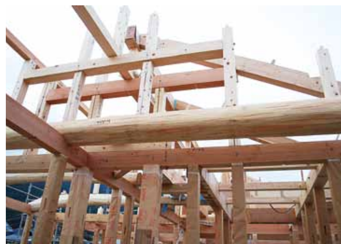
複雑な4段化粧梁は、熟練した工匠ならではの技術で実現。
