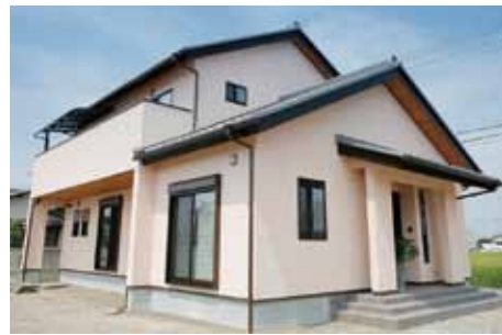
コテ塗り工法によるジュラクペイントの外壁
