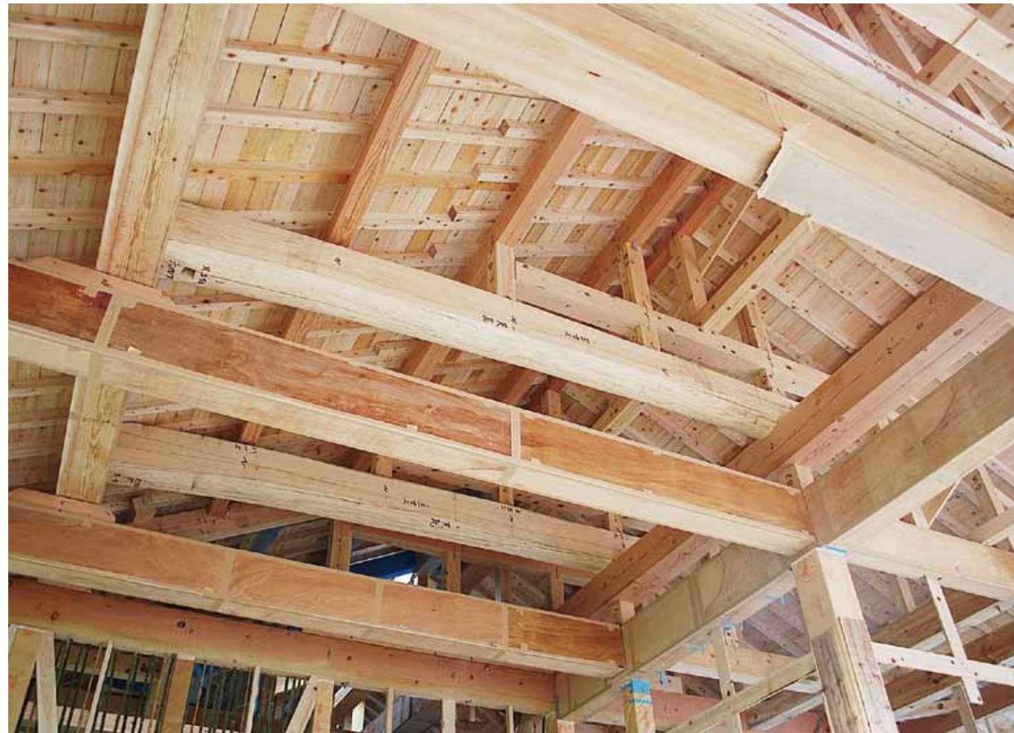
上棟での木組みは、梁一本一本の性質を見極め、工匠による手作業で進められる。(墨付け・切り組み)
