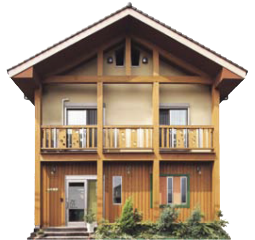
山内建匠「匠舎屋」正面の柱は太さ8寸角、高さは6mにおよぶ。
