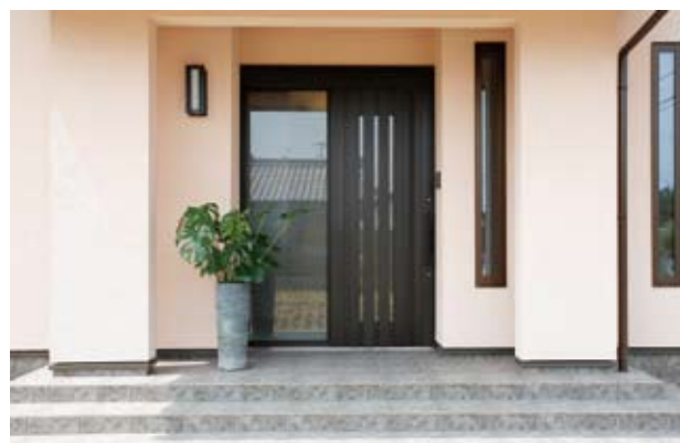
家の顔となる玄関は堂々とした雰囲気。玄関の採光を考えて、扉を引き戸にし半透明なガラスを使用している。
