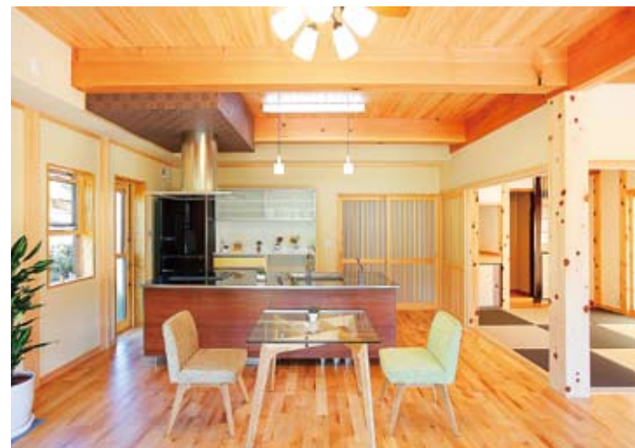
檜の六寸梁、梁天井で力強い印象ながらも、シンプルにまとめられたリビングキッチン。
