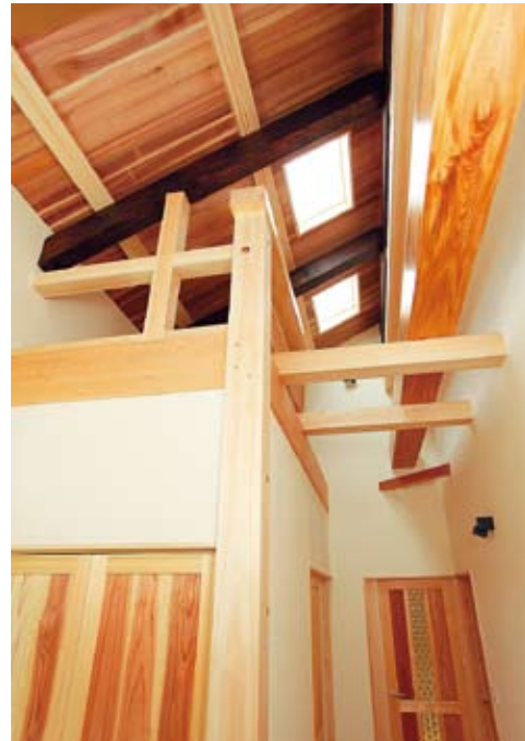
珪藻土、杉葺、檜、登梁、自然素材の意匠が溢れる廊下。
