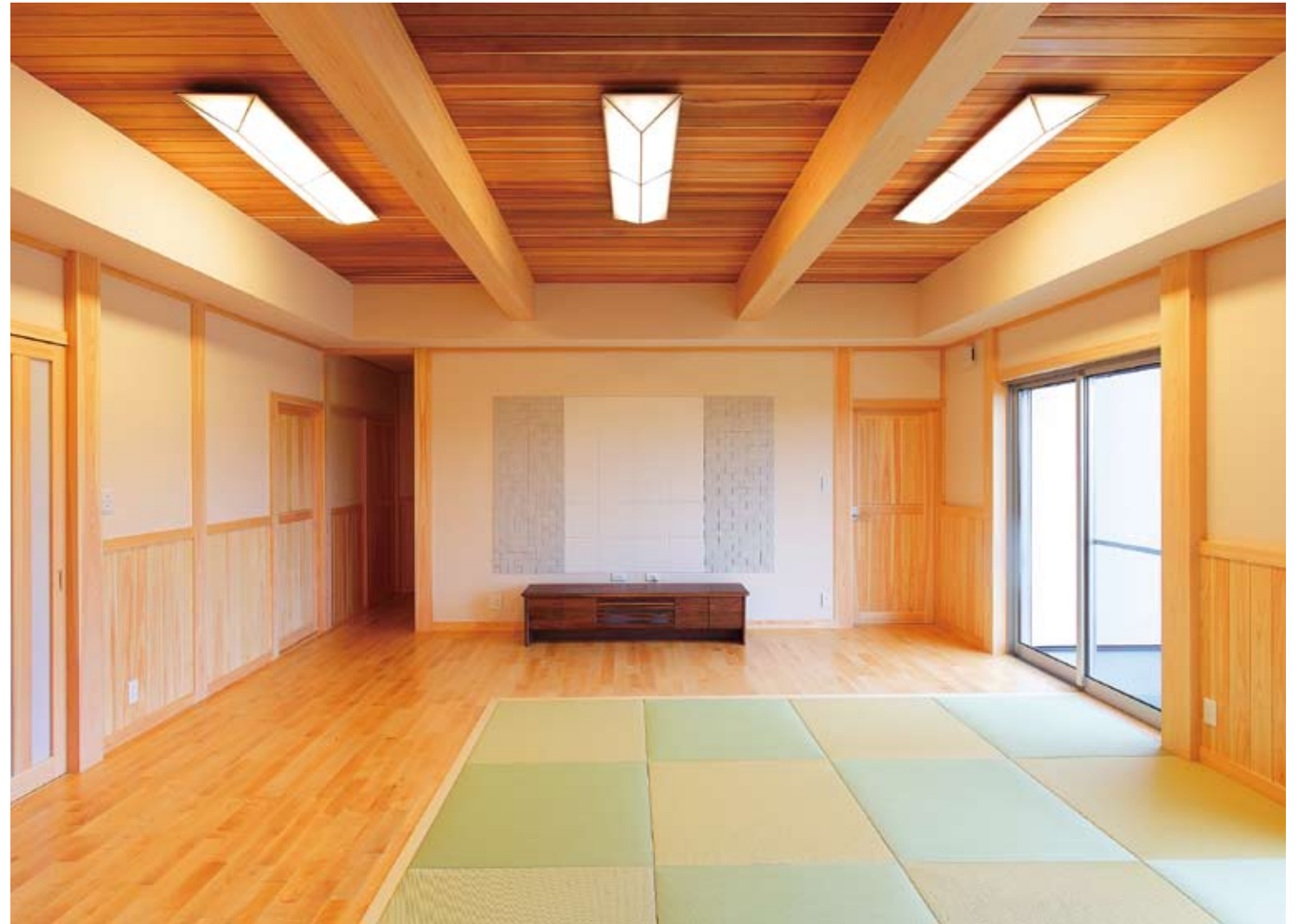
無垢の杉葺(天井)、檜の腰板・梁(6m)、檜の大黒柱。それぞれが主張しすぎず、共生する空間。
