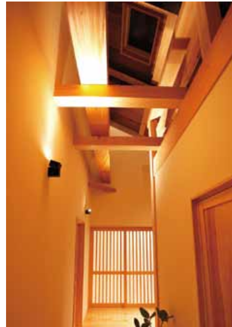
珪藻土、杉柂、樺、登梁、自然素材の意匠が溢れる廊下。
