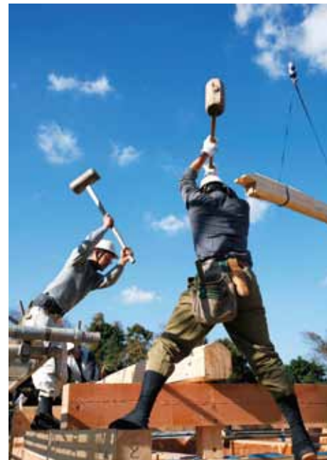
上棟での匠。大工(社長)が筋を振る。(写真手前)
